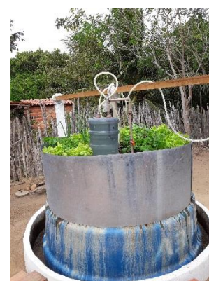
Biodigestor no Assentamento Cajueiro
