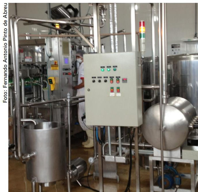
Foto 1. Planta de pasteurização HTST (High Temperature and Short Time).
