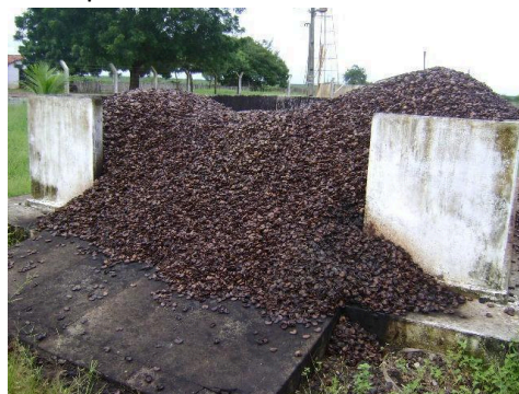
Figura 10. Reservatório para armazenamento da casca da castanha-de-caju.
